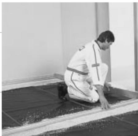
Ora formate una striscia ("dima") larga circa 20 cm lungo un lato della parete, all'incirca dell'altezza del materiale livellante da applicare in seguito. Naturalmente, si deve tenere in considerazione l'altezza della struttura del sistema di sottofondo. Il materiale livellante FERMACELL deve avere un'altezza minima di 10 mm e un'altezza massima
