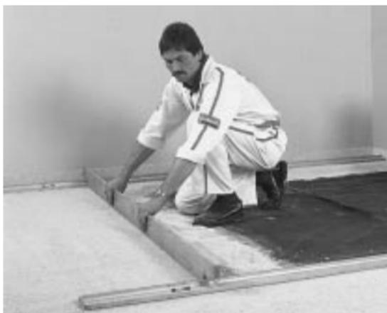
**Dal momento che il materiale livellante FERMACELL non può essere calpestato direttamente, si dovrebbe sempre lavorare verso la porta. Per la posa del sottofondo successivo, procedere utilizzando sempre isole di lavoro, per esempio residui di FERMACELL > 50 x 50 cm.**
