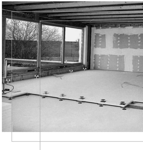
Per mantenere questo clima, durante il montaggio può essere necessario prevedere un riscaldamento rispettando le disposizioni della norma DIN EN 13213 (il clima nella cavità al di sotto del pavimento può differenziarsi solo leggermente dal clima dell'ambiente soprastante ad esso).
